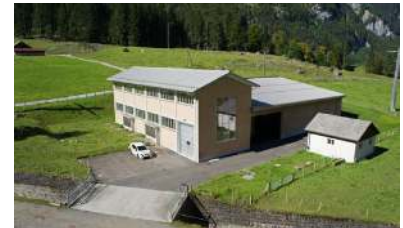
Kraftwerk Hugschwendi, Stöckalp
